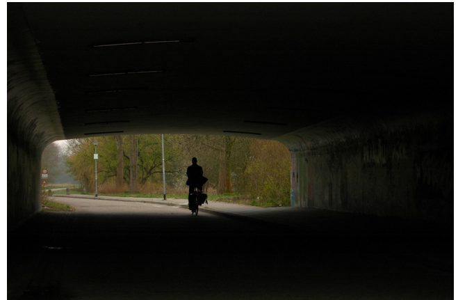
tunnel in Selwerd, Groningen
